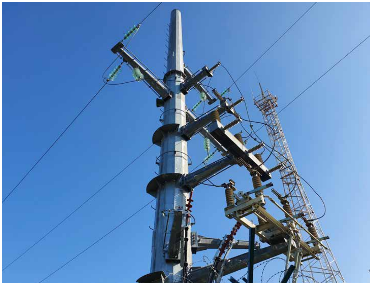
Организация спусков и шлейфов на переходном пункте
