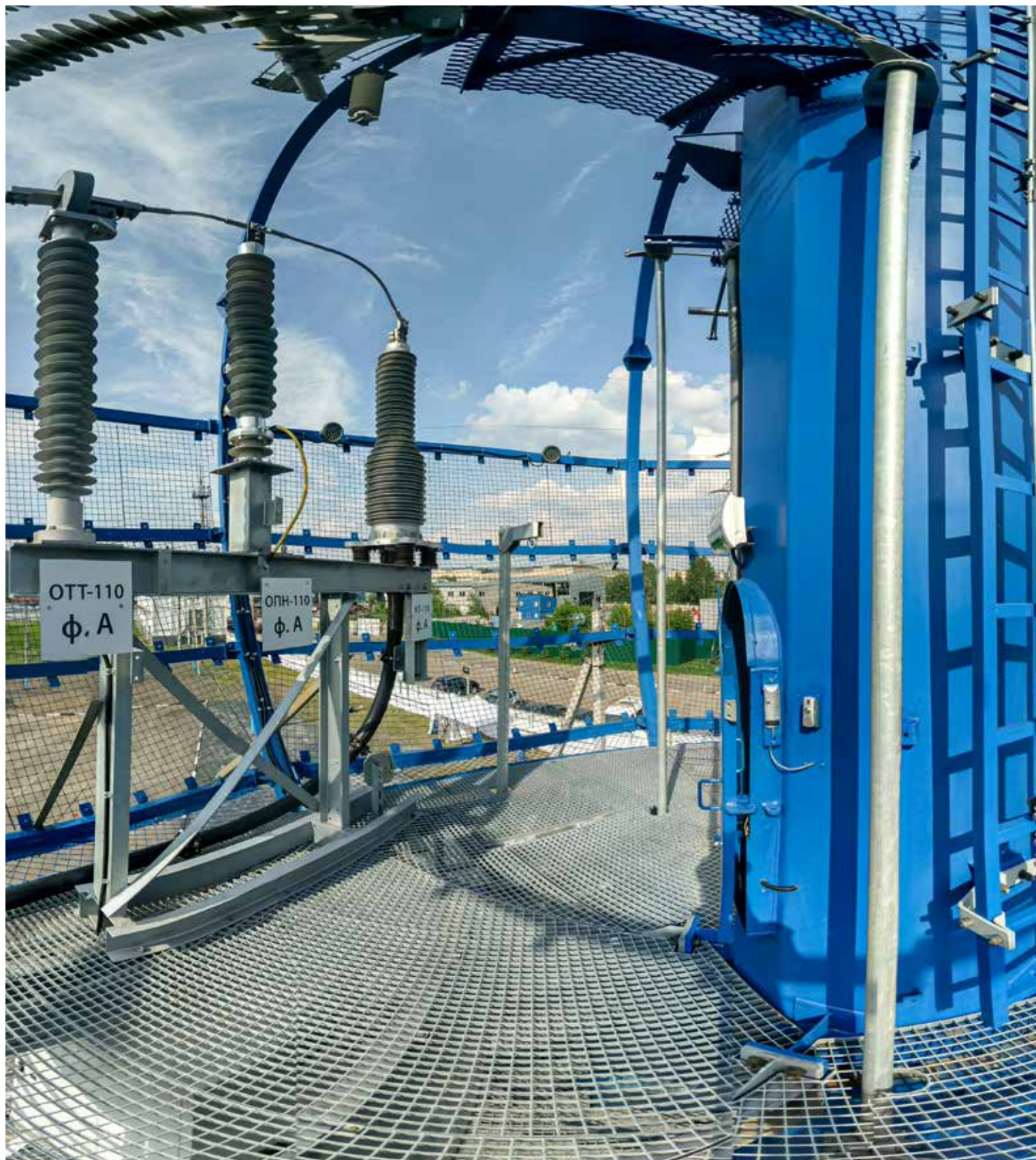
Верхняя эксплуатационная площадка ППМ: на стойке размещены сухая кабельная муфта, ОПН и электронный оптический трансформатор тока; вертикальные однофазные разъединители расположены на стволе опоры
