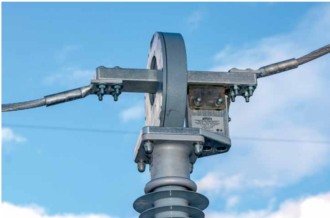
Оптический трансформатор тока для организации селективного АПВ
